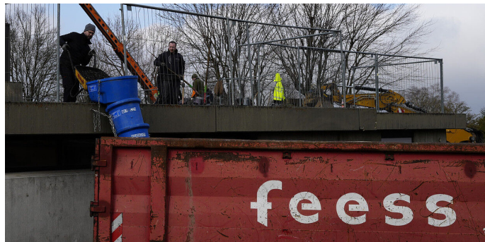
Befüllen des großen Container mit der Dachschüttung der KSH
