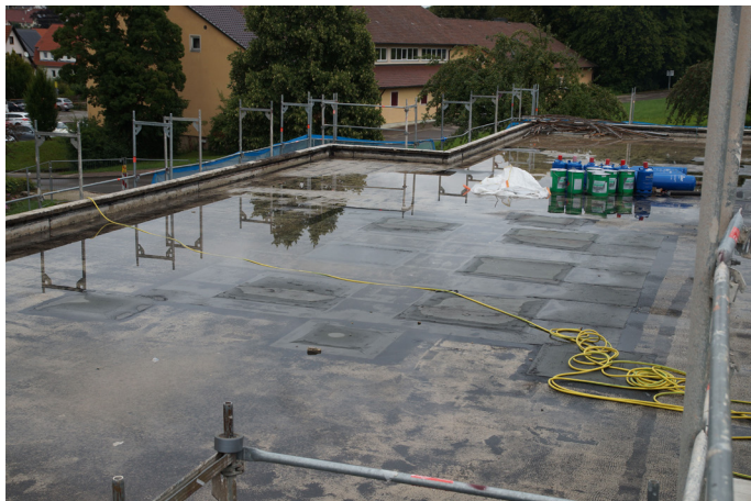
Dachfläche mit verschlossenen Lichtkuppeln
